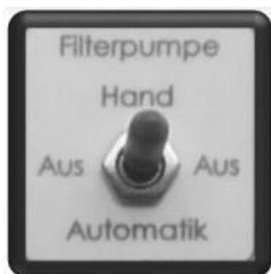
**Ручн. (Hand)** = Ручной режим / Насос в рабочем режиме
