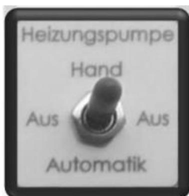
**Выкл (Aus)** = Тепловой насос выключен / Функция нагрева не работает
